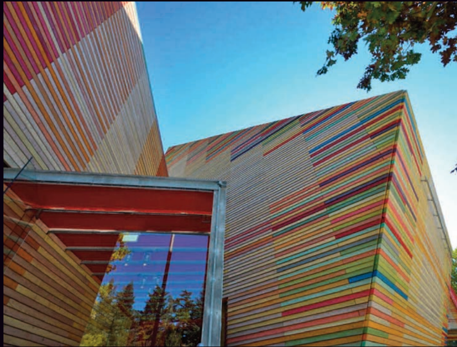
Renzo Piano, Auditorium del Parco, L'AQUILA
